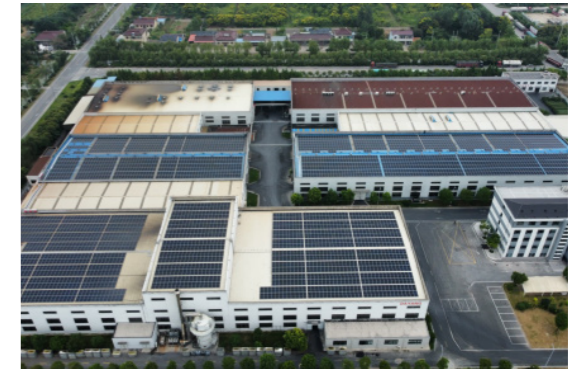
盐城光伏项目铺设
